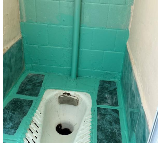
фото № 6. ремонт и покраска задних стен
