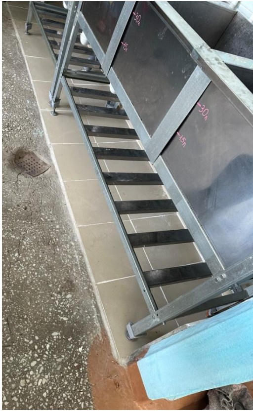
фото № 9. Облицовка плиткой моечной зоны
