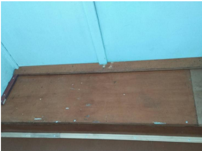
Фото № 7. Заделка плинтусом
