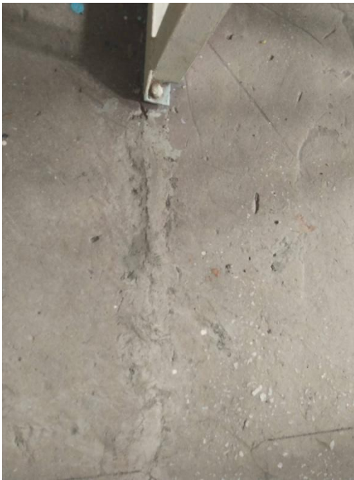
фото №3 заделывание бетонного пола
