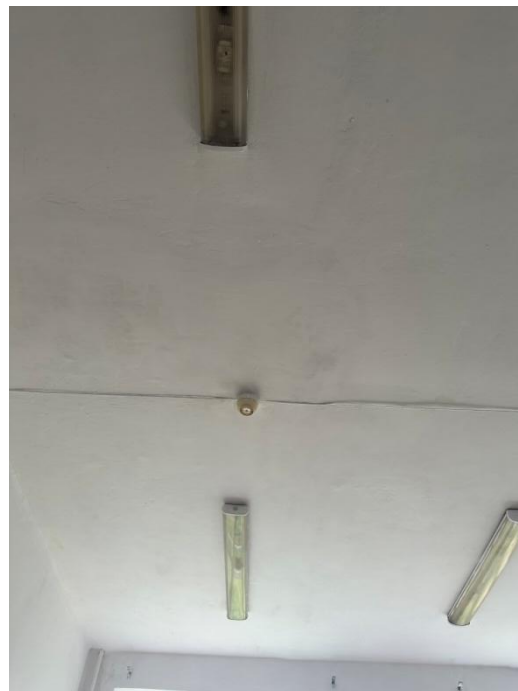
фото № 4. Ремонт потолка
