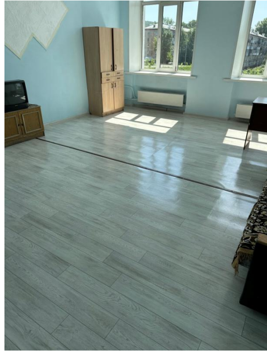
фото № 2. Замена линолеума
